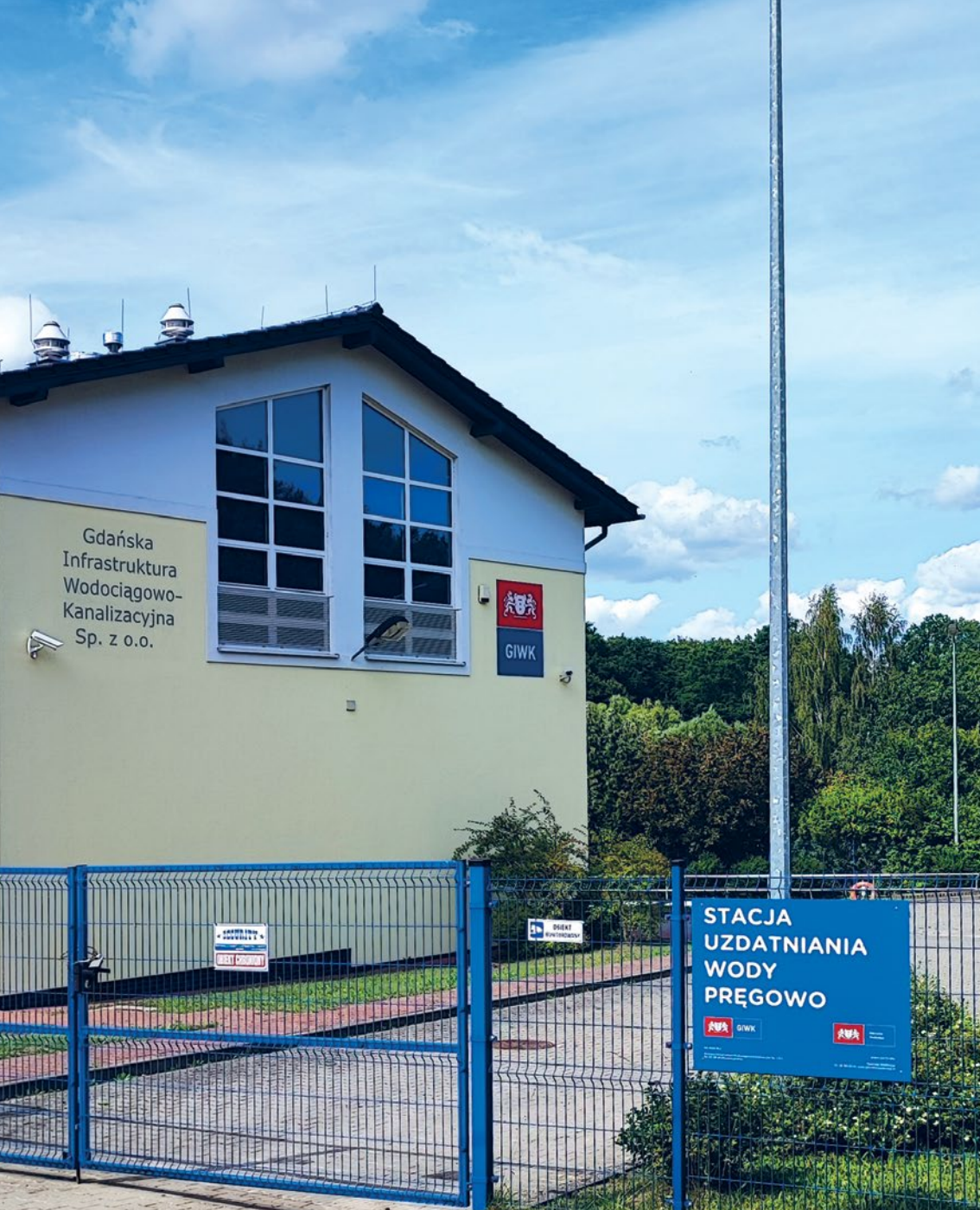
Budynek stacji uzdatniania wody ujęcia Pręgowo
