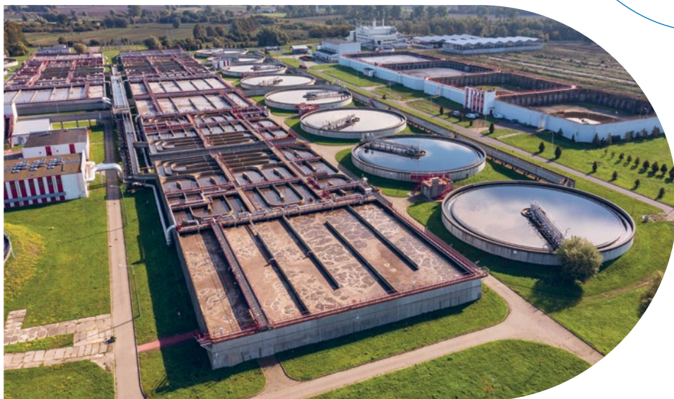
Bioreaktory — biologiczny etap procesu oczyszczania ścieków
